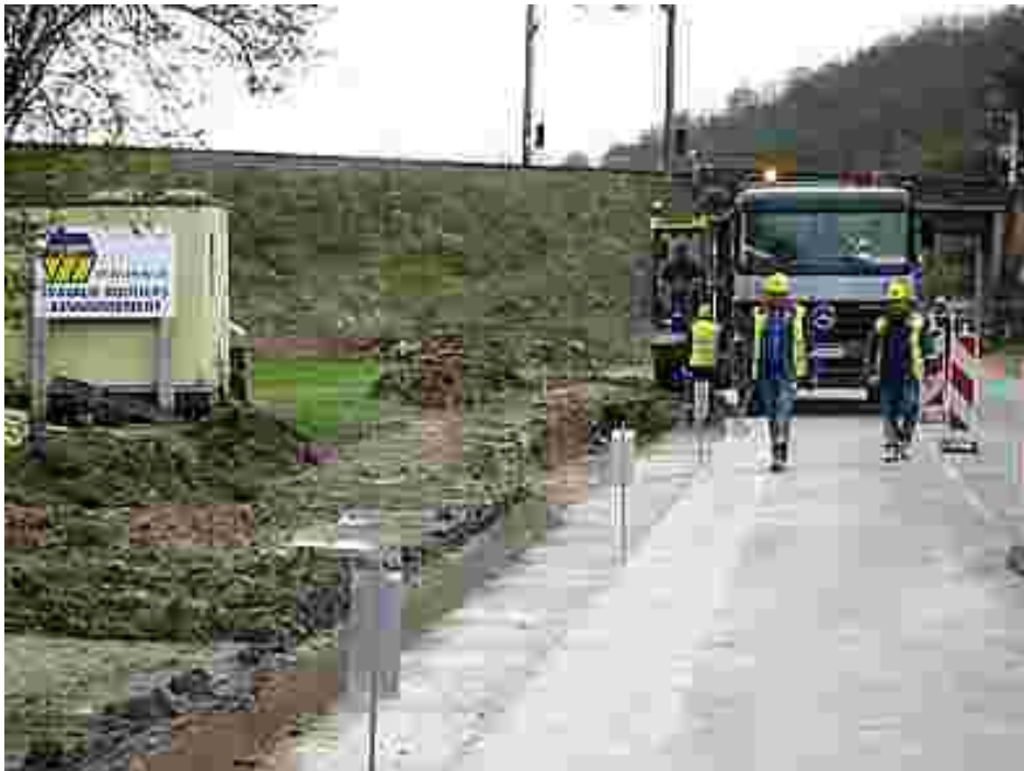
Réalisation de purges localisées 35€ /m 2 (entreprise)
