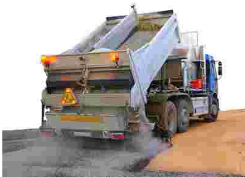
Réalisation d'enduits superficiels 14 000 € /km de route traitée (entreprise)
