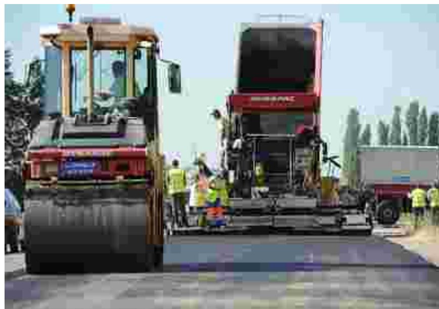
Réalisation d'enrobés (bétons bitumineux) 85 000 € /km de route traitée (entreprise)
